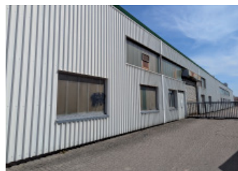
Fabrik RVV Rohrssen
